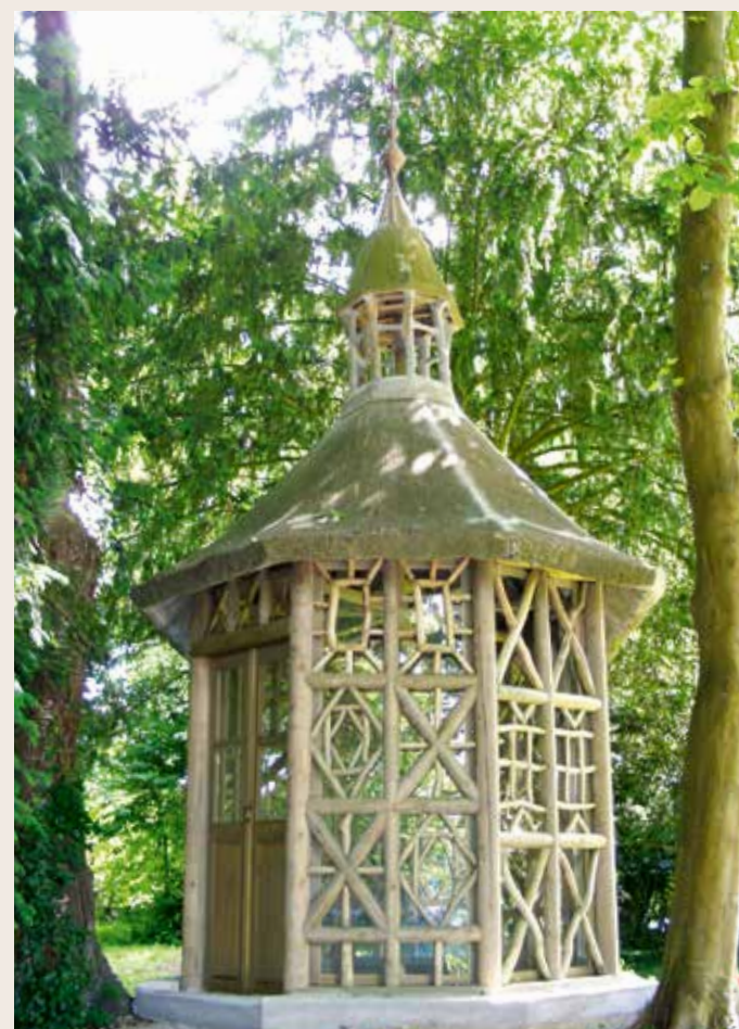
Gloriette réhabilitée par l'architecte Philippe LOYER
